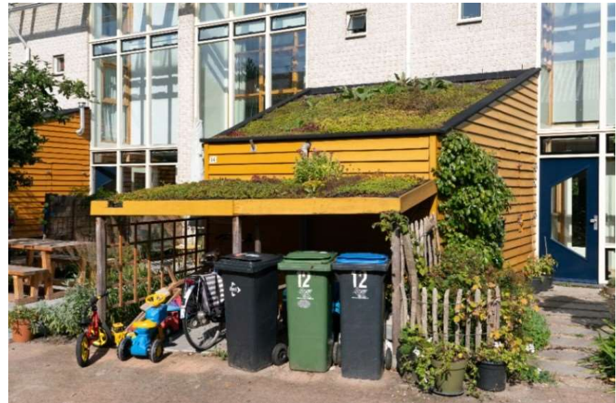
Voorbeeld van groen dak
