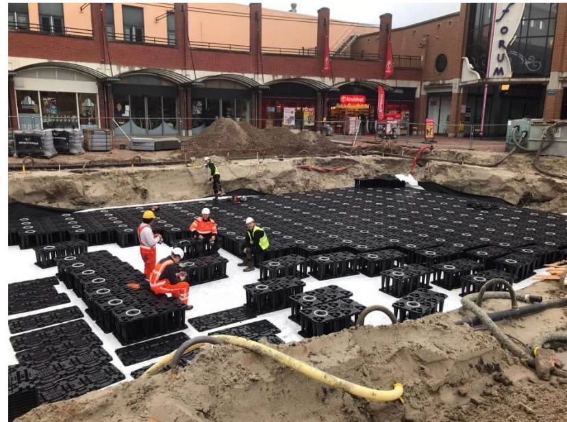
Aanleg stormharvester op Koopmansplein
