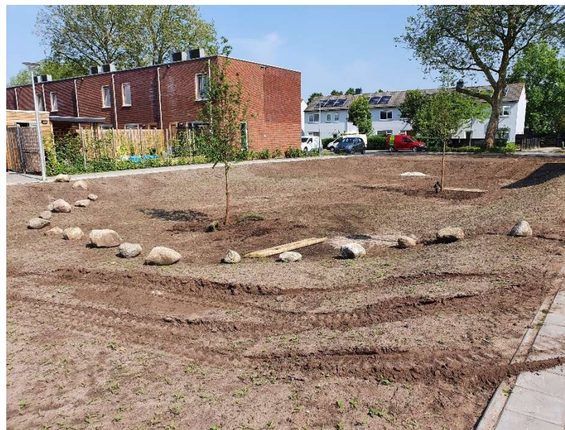
Wadi in aanleg
