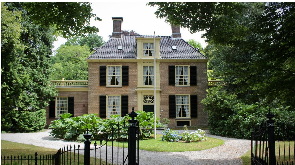
Landgoed Overcingel wordt tegenwoordig beheerd door Het Drentse Landschap. Het woonhuis wordt in 2023 gerestaureerd, gedeeltelijk herbestemd en verduurzaamd.
