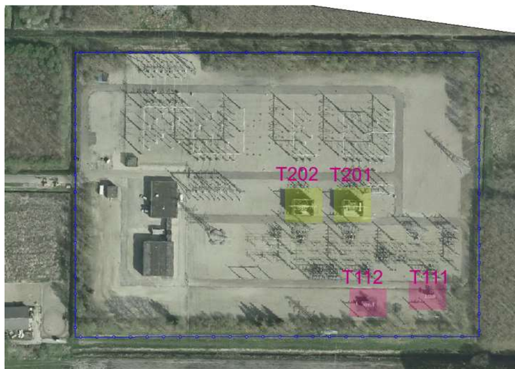
Figuur 3.4 huidige transformatoren op transformatorstation Zeijerveen
