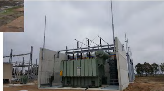
◆ Transformatorput 12.8m. x 11.7m. x 6.5m.
