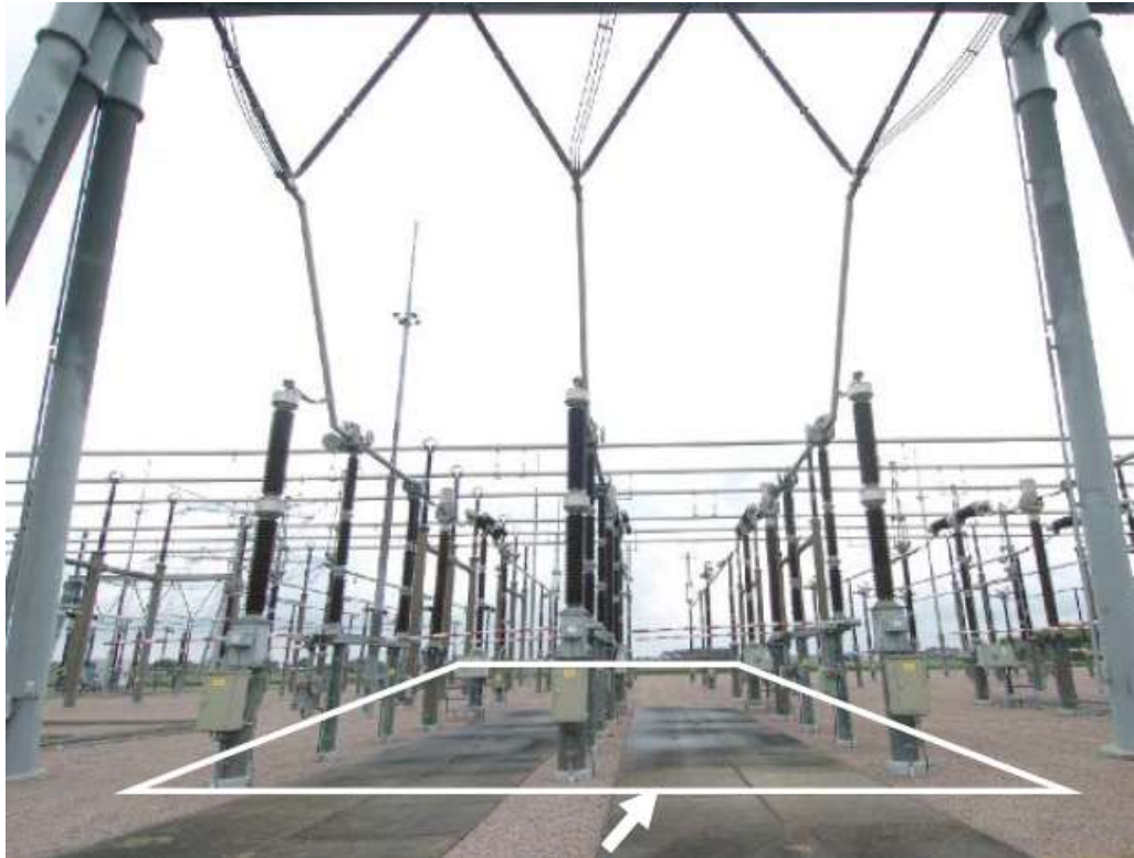
Figuur 4.9 Illustratie transformatorveld met bliksemafleiders
