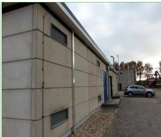
Kantoorpand met de zijde waar de uitbreiding gerealiseerd zal worden.
