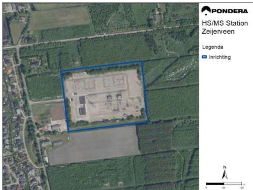
Figuur 1.2 Ligging van het transformatorstation (blauw omlijnd)
