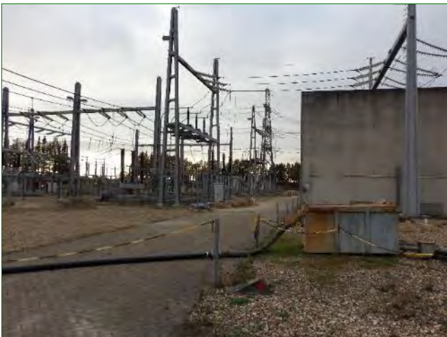
Het middenterrein met rechts de ventilatorgebouwen.
