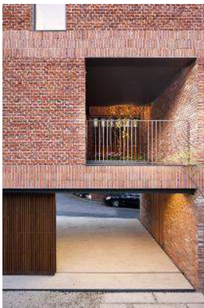
Parkeren onder het gebouw
