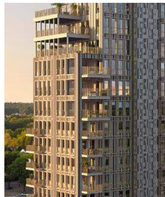
Mooie belijning en reliëf in beton
