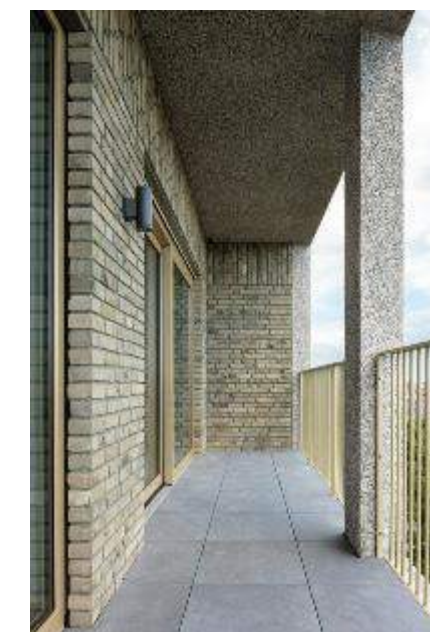
Galerij die er niet uit ziet als een galerij met een gevel aan de buitenzijde, mee ontworpen met het gebouw (en niet eraan gehangen)
