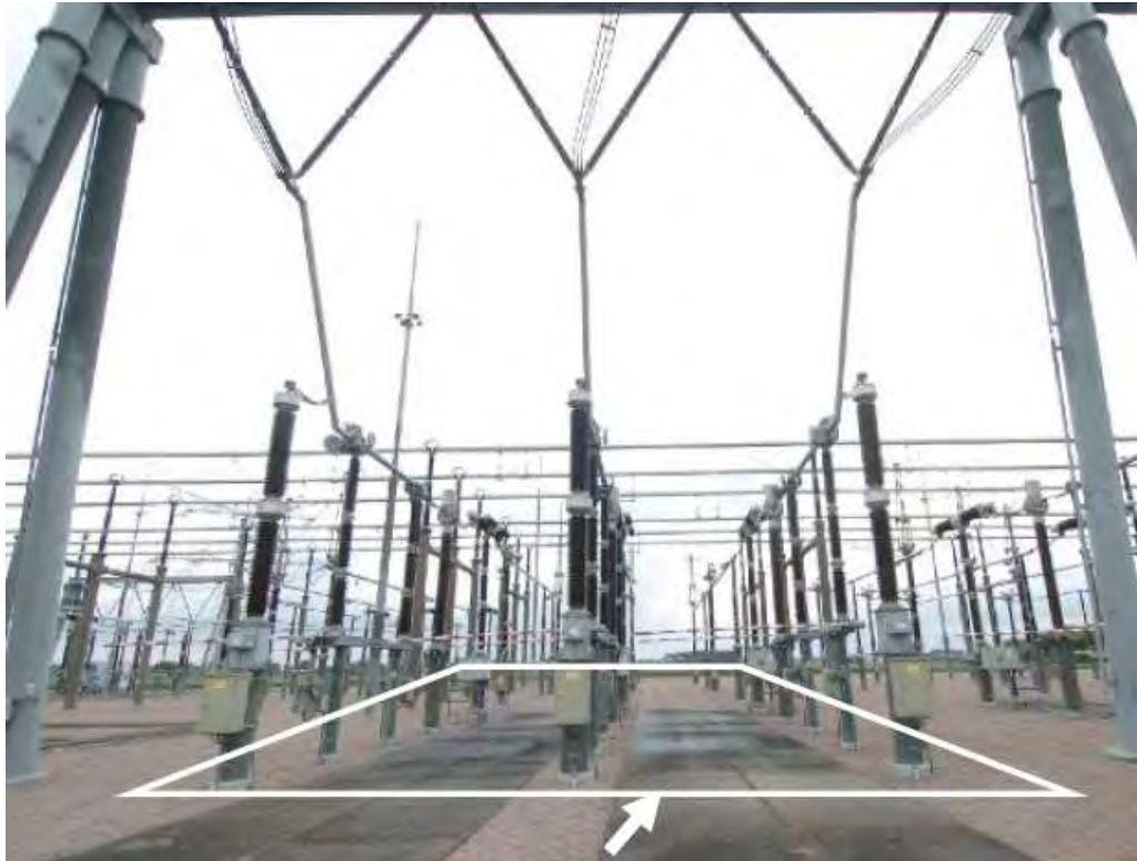
Figuur 4.8 Illustratie transformatorveld met bliksemafleiders
