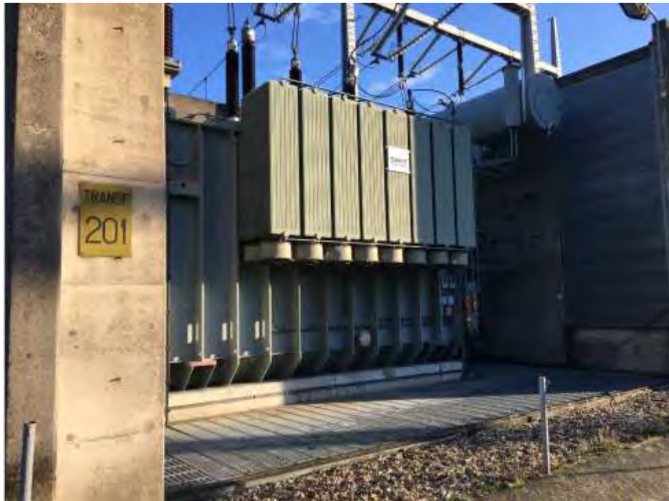
Figuur 4.5 Bestaande koppeltransformator in transformatorcel
