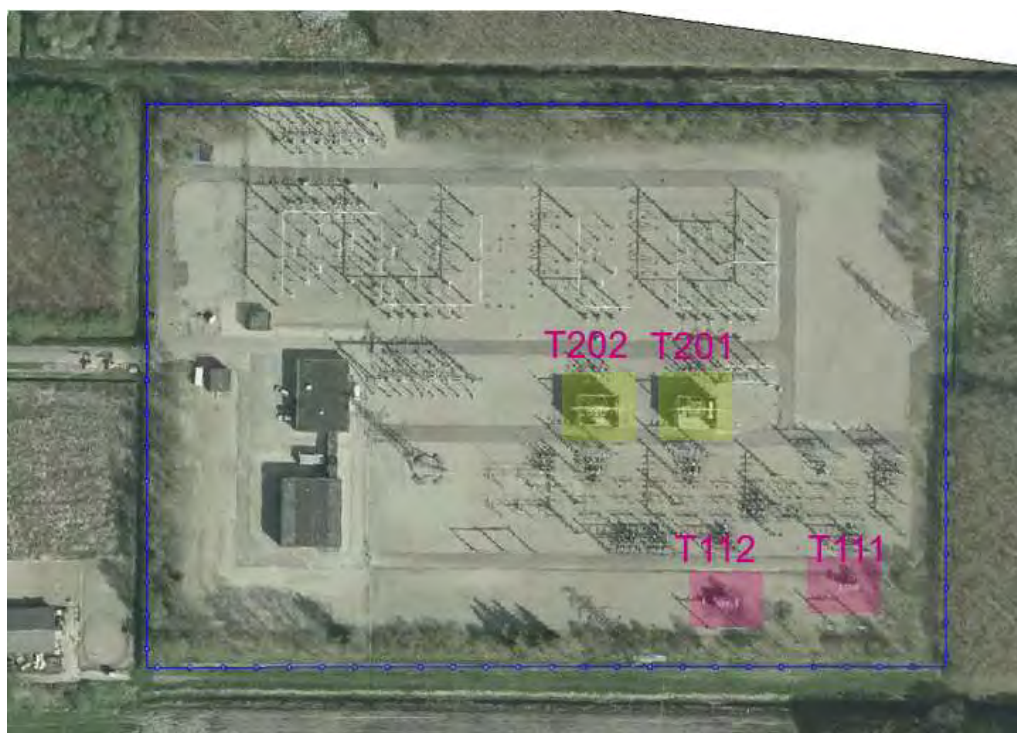
Figuur 3.4 huidige transformatoren op transformatorstation Zeijerveen
