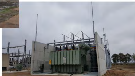
◆ Transformatorput 12.8m. x 11.7m. x 6.5m.
