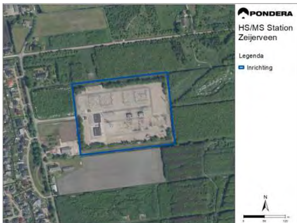
Figuur 1.2 Ligging van het transformatorstation (blauw omlijnd)
