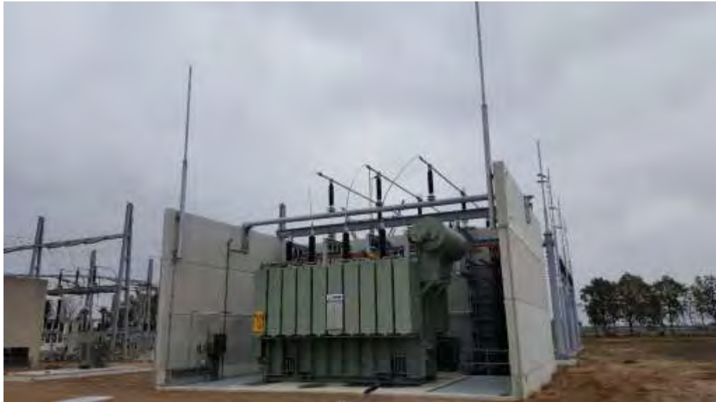
Figuur 4.2 illustratie transformator/transformatorcel met bliksemafleiders
