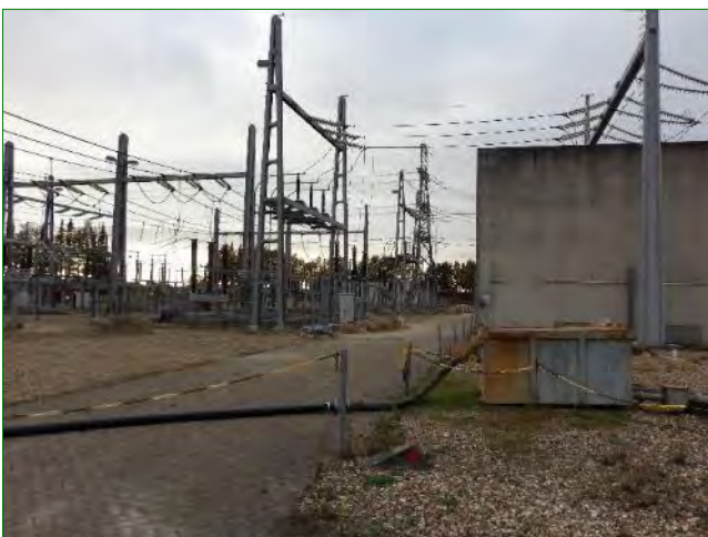
Het middenterrein met rechts de ventilatorgebouwen.
