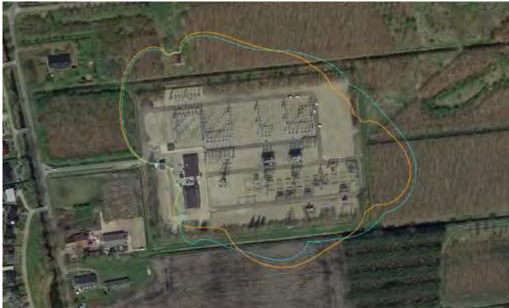
Figuur 5.5 Ligging magneetveldzone rond transformatorstation Zeijerveen (inclusief invloed hoogspanningsmasten buiten het station). Huidige situatie: oranje. Toekomstige situatie: cyaan.
