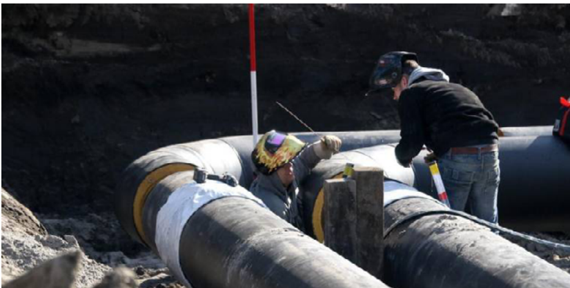
Aanleg warmtenet Bron: Dagblad van het Noorden
